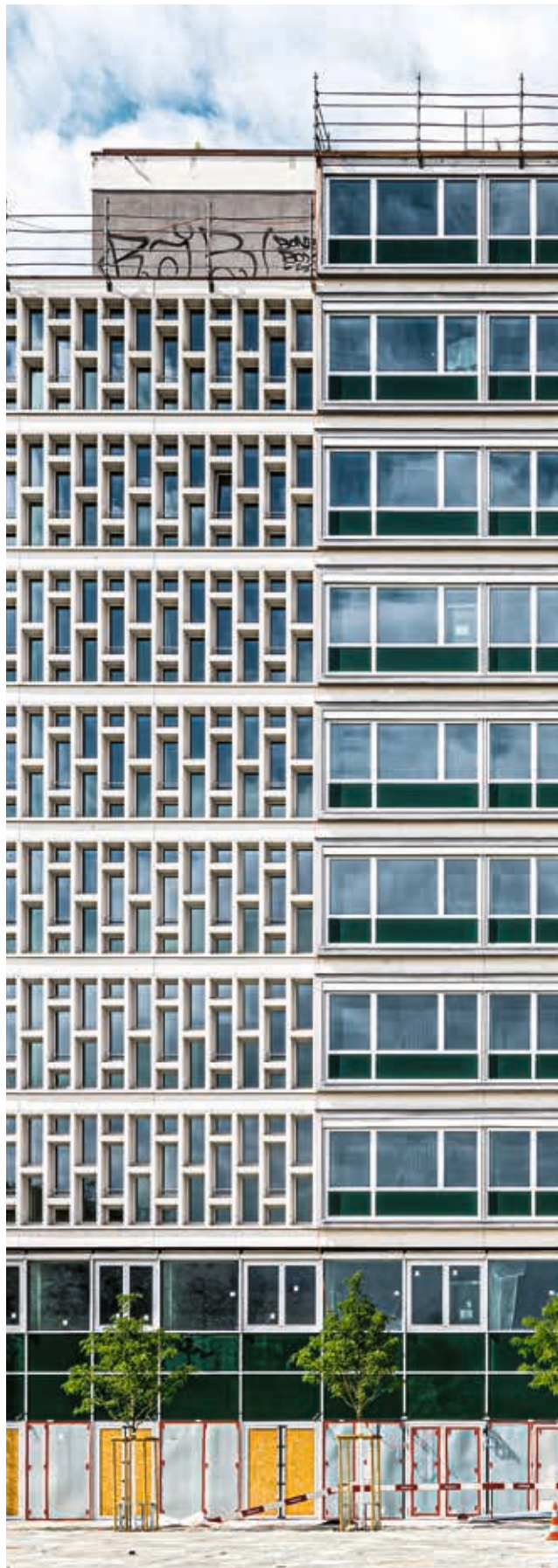
Auf der Nordfassade stossen die zwei Extreme aufeinander – die Betonfertigteilefassade (links) erfuhr bei den Umbauarbeiten den geringsten Eingriff, wohingegen die Metallrahmenfassade (rechts) komplett ausgetauscht wurde.
