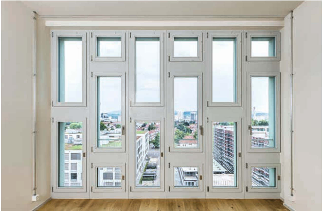
Die innere Betonfertigteillfassade hat neue Fenster erhalten , die die Planenden in der Ansichtsbreite und der Farbe möglichst gleich wählten wie die ersetzten Fenster. Aus den dahinterliegenden Zimmern hat man einen wunderbaren Blick auf die Stadt.
